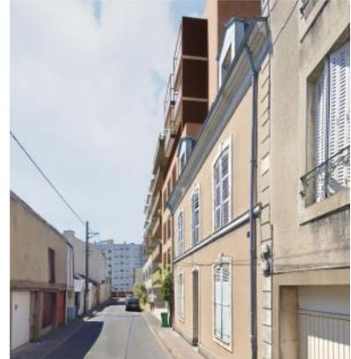
Découpe volumétrique en verticale avec une matérialité différente / Découpe volumétrique en horizontale avec des loggias dans les niveaux inférieurs / Balcons découpés de la façade en finition tôle / Variation de typologie de garde-corps / Béton lasuré en trois teintes différentes + menuiseries et tableaux laqués en ton dito façade
