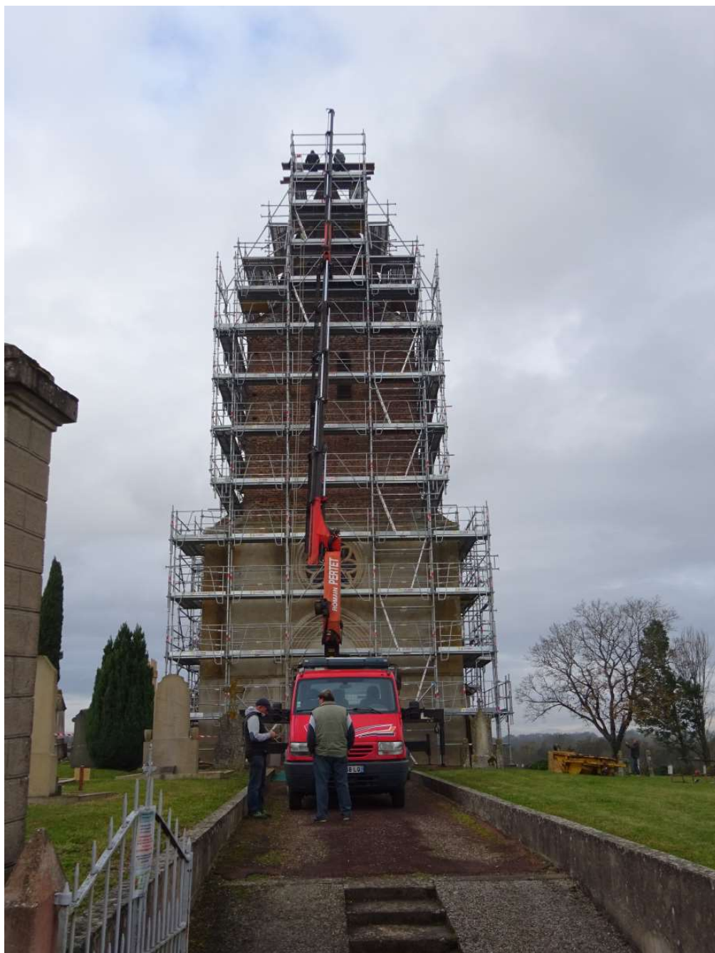
Mise en place de l'échafaudage sur le clocher
