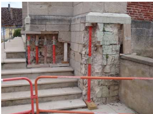
Etalement du contreforts en cours de restauration. Les pierres dégradées ont été déposées
