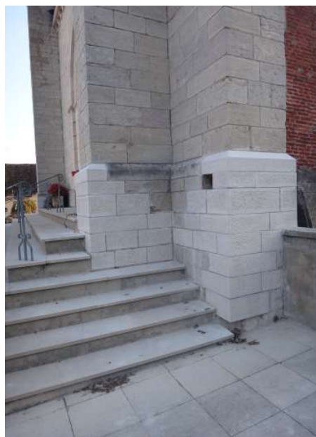
Blocs de pierre de taille remplacés avec une pierre plus résistante à la compression
