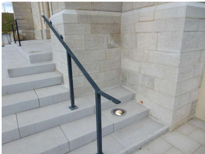
Blocs de pierre de taille remplacés avec une pierre plus résistante à la compression
