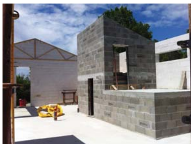
maison d'habitation 47780 Agnac, Lot et Garonne chantier en cours
