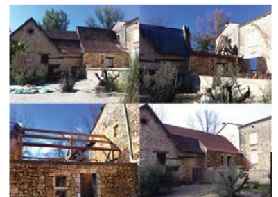
restauration maisons 24510 St Marcel du Périgord, Dordogne chantier en cours
