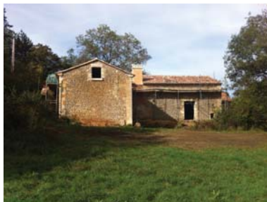
restauration moulin 24510 Saint Laurent des Batons livraison septembre 2014
