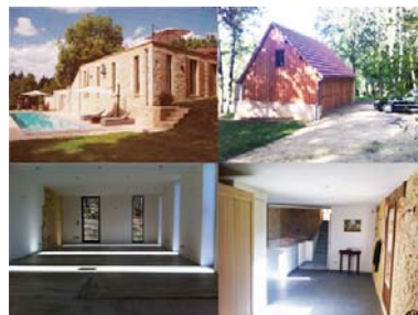
rénovation 2 maisons, une gîte et une cabane, restauration séchoir à tabac, transformation un garage aux 2 studios et création d'une piscine
