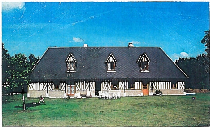
APRÈS : Façade principale, après travaux
