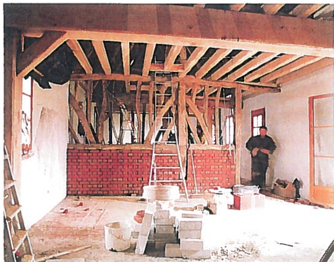
PENDANT : Salon (mur en cours de transplantation et sommier chène chêne), pendant les travaux
