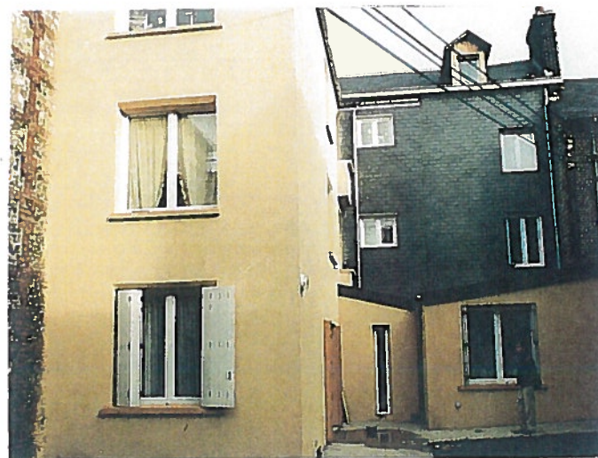
Les façades Sud après les travaux (APRÈS)
