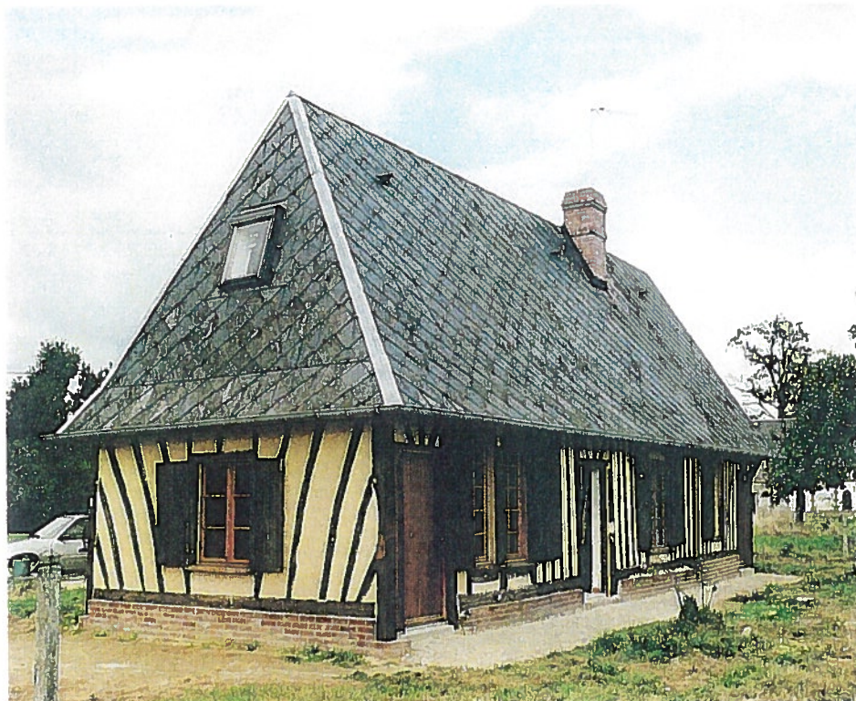
Après : vue Sud-Ouest, façade Sud et pignon Ouest.
