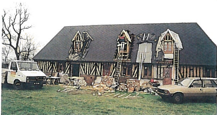
PENDANT: La façade Sud pendant les travaux
