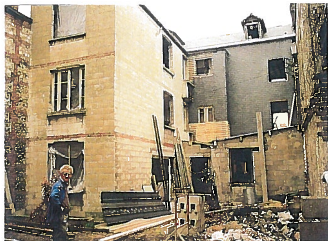
Les façades Sud pendant les travaux (PENDANT)
