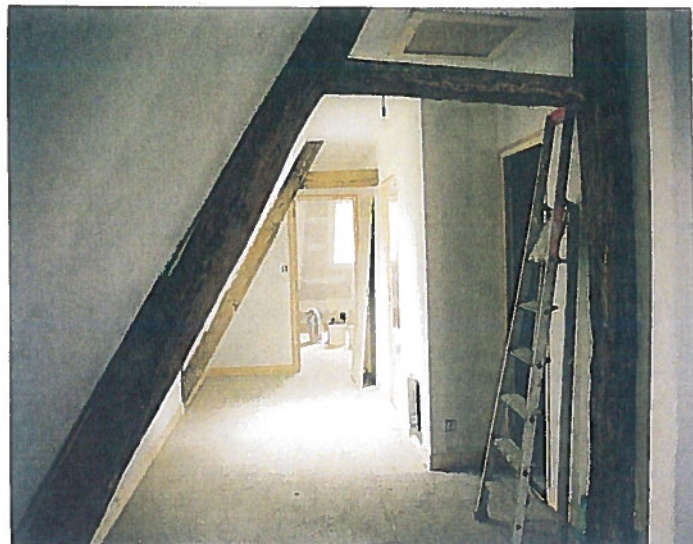
APRÈS : Combles aménagés (dégagements), après travaux
