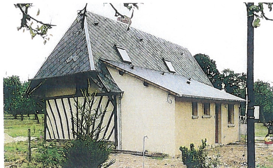
Après : vue Nord-Est, façade Nord et pignons Est.
