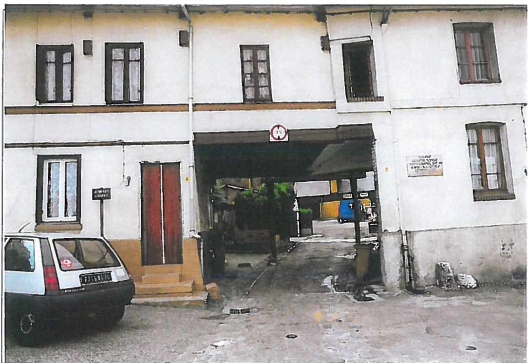
Côté rue (façade nord)
