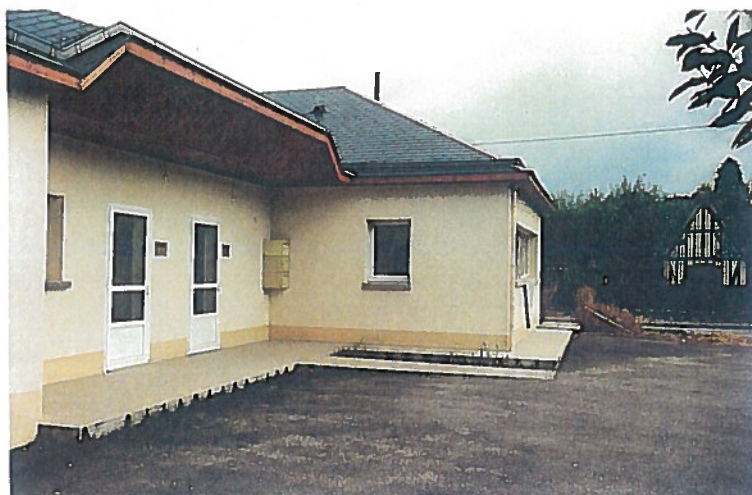
APRÈS : Façade Nord-Est/Nord-Ouest
