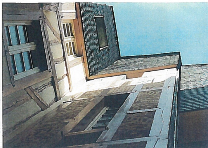
APRÈS : Vue d'ensemble sur les façades Sud et Est
