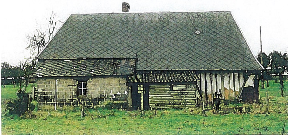
Avant : vue sur la façade Nord.
