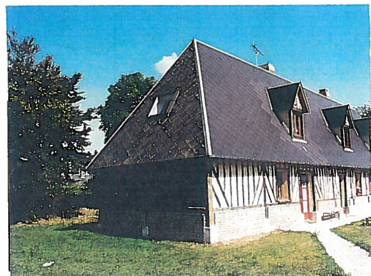
APRÈS : La façade Sud après les travaux
