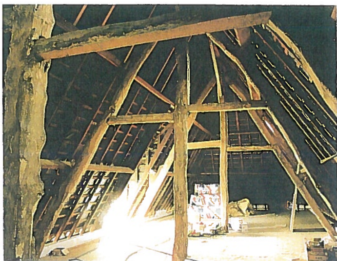
PENDANT : Charpente existante pendant les travaux avant l'aménagement des combles
