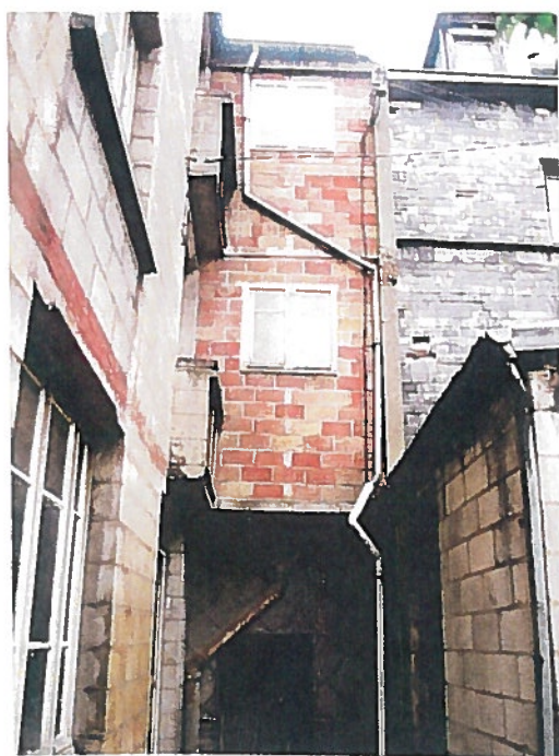
Vue de détail sur les façades Sud (AVANT)
