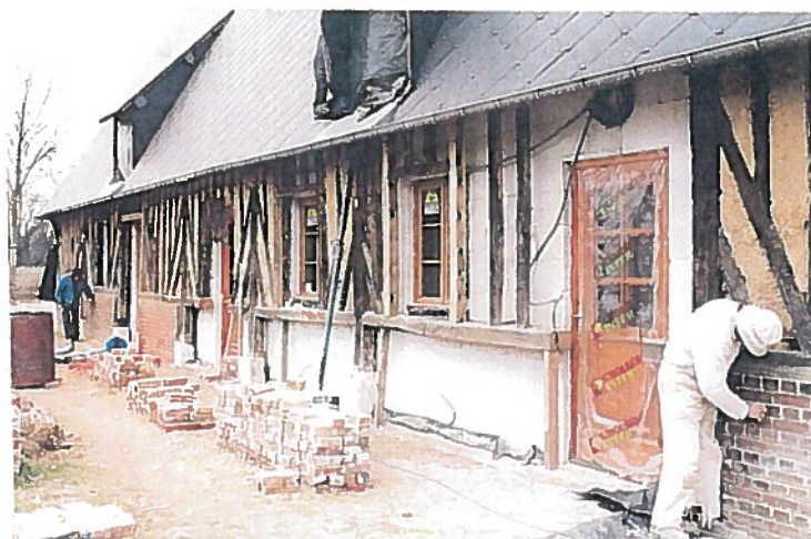
PENDANT: Détail de la façade Sud pendant les travaux
