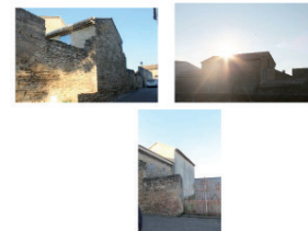
CAMPAGNE DE RAVALEMENT DE FACADE - COMMUNE DE CODOLET
