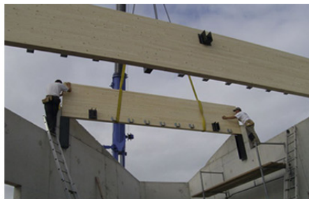
MONTAGE DE LA CHARPENTE
