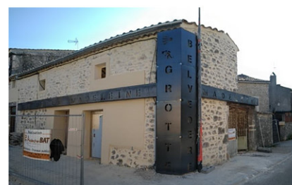
CHANTIER EN COURS AVRIL 2020
