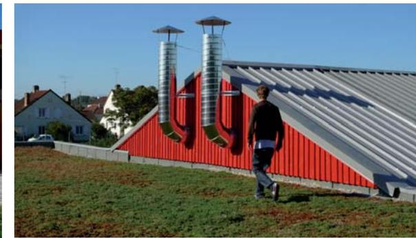
**01. & 02. Le bâtiment existant et l'extension :** L'extension est réalisée en ossature bois. Les façades de l'extension sont réalisées en bardage essence douglas à joints à recouvrement. La toiture est portée par des portiques en bois.
