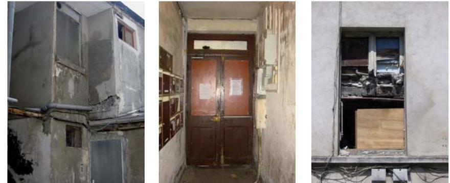
à risque de retrait plomb s'est déroulé avec l'organisme préfectoral URACA. Les principaux travaux ont été la suppression de l'accessibilité au plomb, la couverture, les réseaux, EU, EV, la mise au norme du réseau électrique, le ravalement et quelques reprises structurelles...
