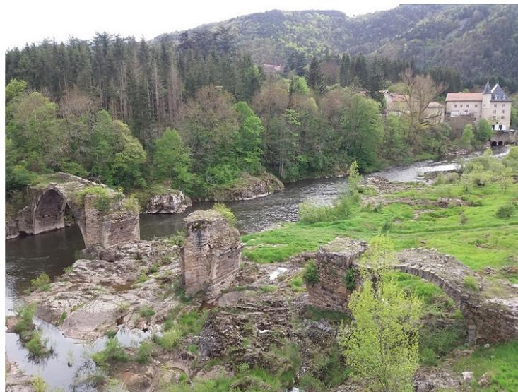
Le projet prévoit avant tout une consolidation-restauration traditionnelle des maçonneries : enlèvement de la végétation, nettoyage, reprise des joints, confortement structurel des piles, remaillage des fissures, protection sommitale.
