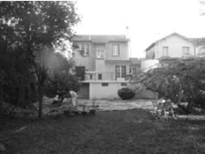
Vue de l'existant
