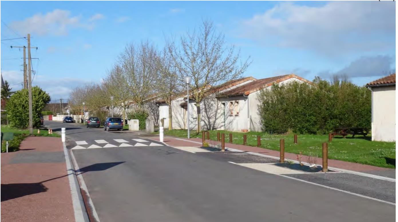
La rue de Rigny après travaux (T1 et T2)
