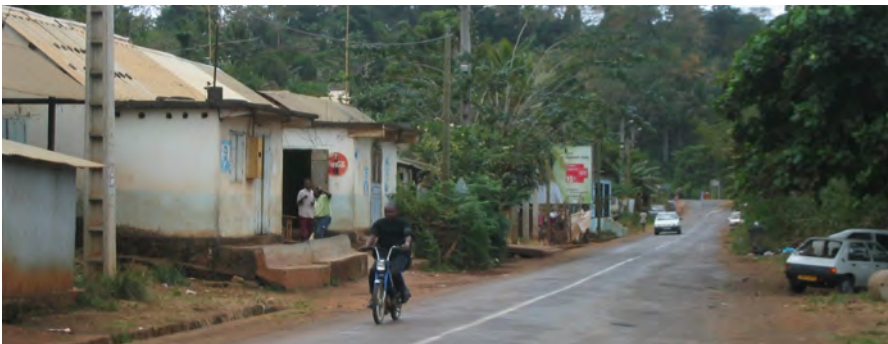
700m de ligne droite sans aménagement état existant
