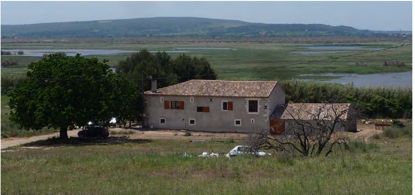
La bergerie du domaine de la Gairarde en phase de réception des travaux
