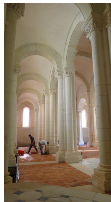
Chantier de calepinage
