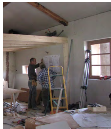
Sur le chantier
