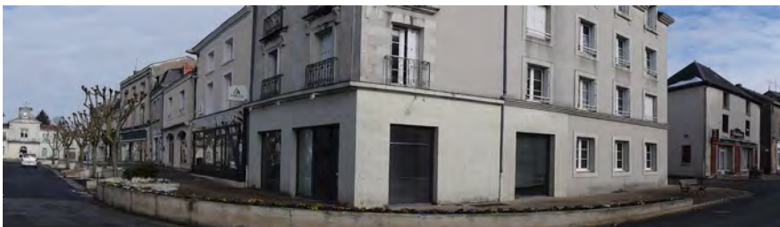
Etat avant travaux
