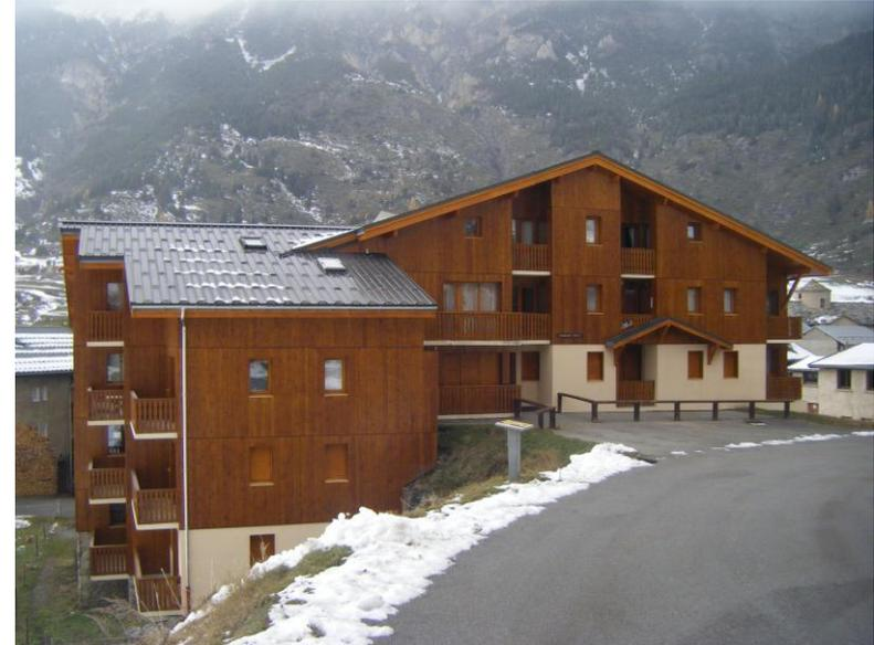
*Ravalement des façades copropriété « Résidence Belle » par la mise en place d'une isolation par l'extérieur sous bardage neuf et sous enduit en soubassement – Lanslevillard (73)*
