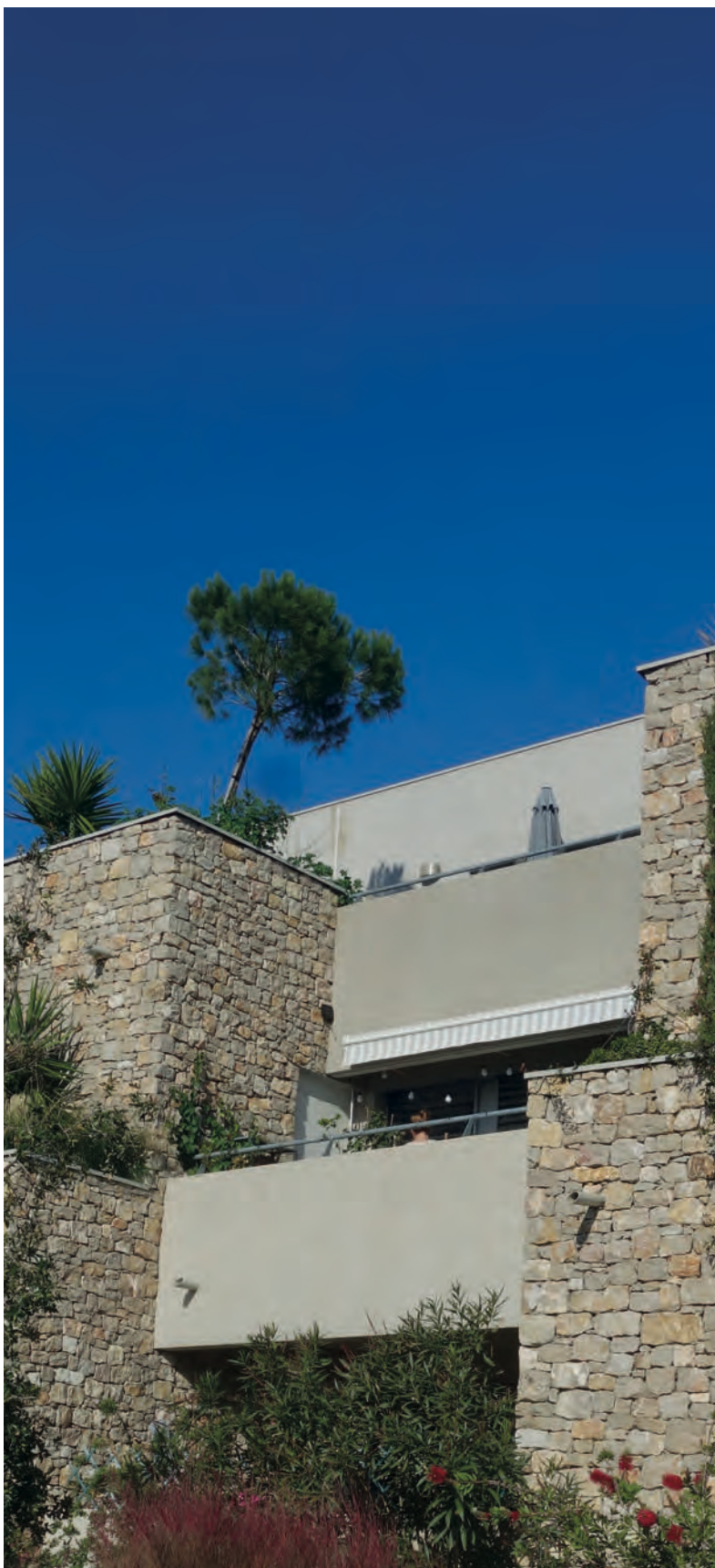
Logements sociaux, au Crès: les roches déblayées pour construire ces bâtiments ont finalement été récupérées pour habiller leurs façades. © HMR
