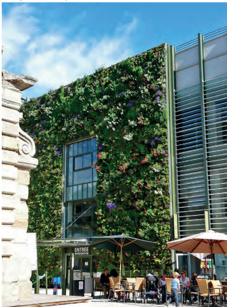
Le mur végétalisé de la serre amazonienne, au zoo Lunaret à Montpellier, avant que du détergent ne fasse crever les plantes.
