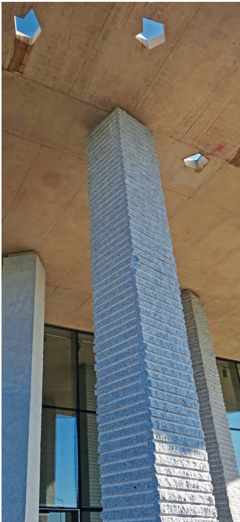
François Fontès prône le retour à l'utilisation des matériaux locaux. Ici la colonnade de l'Agora au Crès, en granit du Tarn. © HMR
