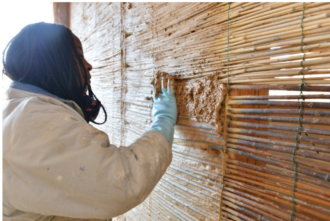
Pose de l'enduit terre sur roseau.
