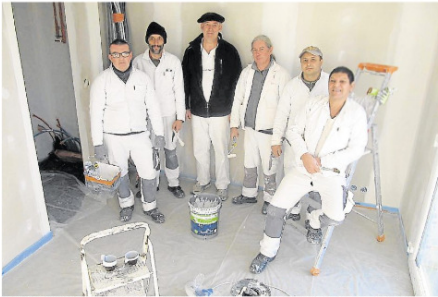
Les futurs voisins de la résidence l'Odysée, presque au complet sur le chantier d'un logement. De gauche à droite : Mickaël, Christian, Philippe Cadi, le monsieur Eric, Albert, citoyen Arménien, et German, venu de Colombie.
