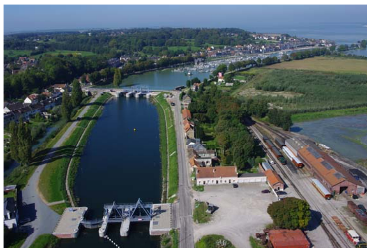
Aménagement du site de Saint Valéry sur Somme
