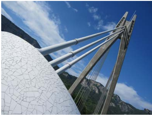
Pont aval de Bonneville
