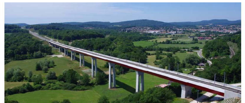
LGV Rhin Rhône - Viaduc de la Lizaine
