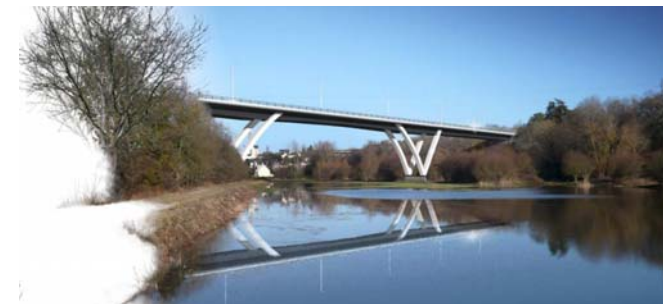
Viaduc sur le Brivet - Pontchâteau
