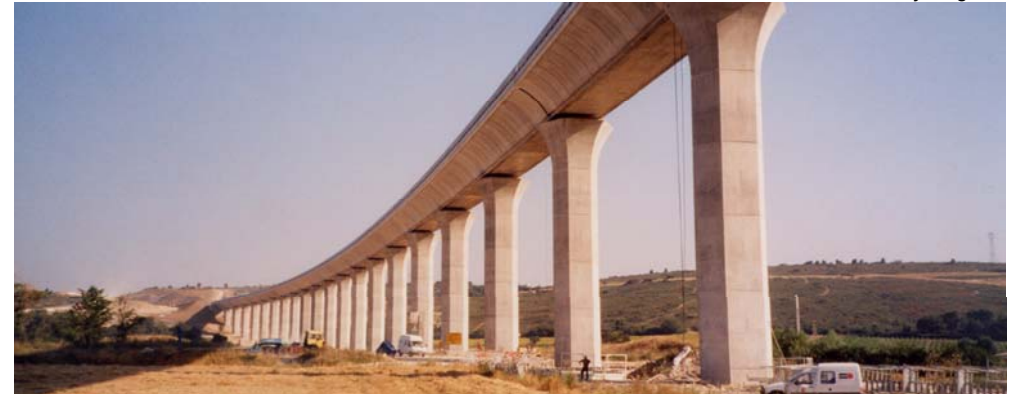
LGV Méditerranée - viaduc de Ventabren
