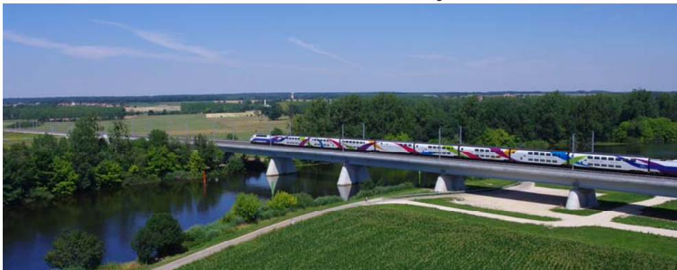
LGV Rhin Rhône - viaduc de la Saône
