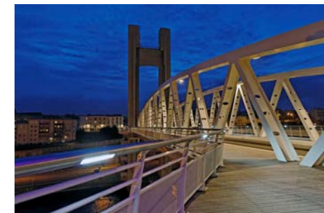
Réhabilitation du Pont de Recouvrance - Brest
