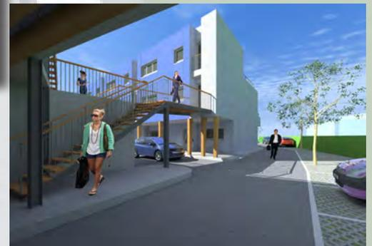
**INFOS.** LOCALISATION : Saint-Martin du Tertre, Val d'Oise (95). MAITRE D'OUVRAGE : Val d'Oise Habitat. MAITRE D'OEUVRE : Manuel Delluc Architecte. B.E.T. : Intégrale 4. PROGRAMME : 14 logements H.P.E. 5 F4, 7 F3, 2 F2. SURFACE (SH0N) : 1267 m<sup>2</sup>. STRUCTURE : construction à ossature bois, façade en bardage bois. COUT : 1 500 888 Euros HT. MISSION : Consultation, étude libre en procédure adaptée, non retenue. PERIODE : 2010.
