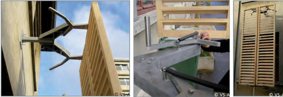
Prototype éch.1 réalisé par le bureau en phase APD : volets bois manuels déportés de la façade avec un mécanisme en aluminium.
