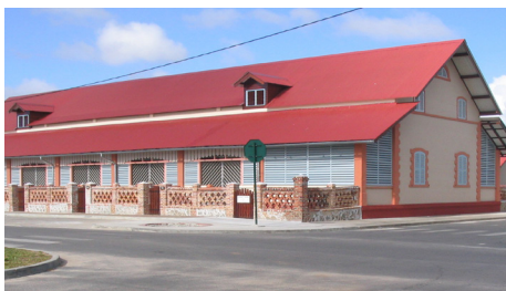
RÉHABILITATION DE 9 LLS ST-LAURENT-DU-MARONI
