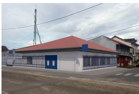
RÉHABILITATION DE L'AGENCE BFC ST-LAURENT-DU-MARONI
