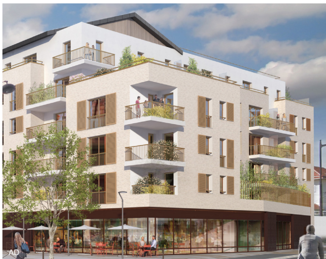
RUEIL-MALMAISON 180 LOGEMENTS + 2 COMMERCES - BECARE - proue du bâtiment
