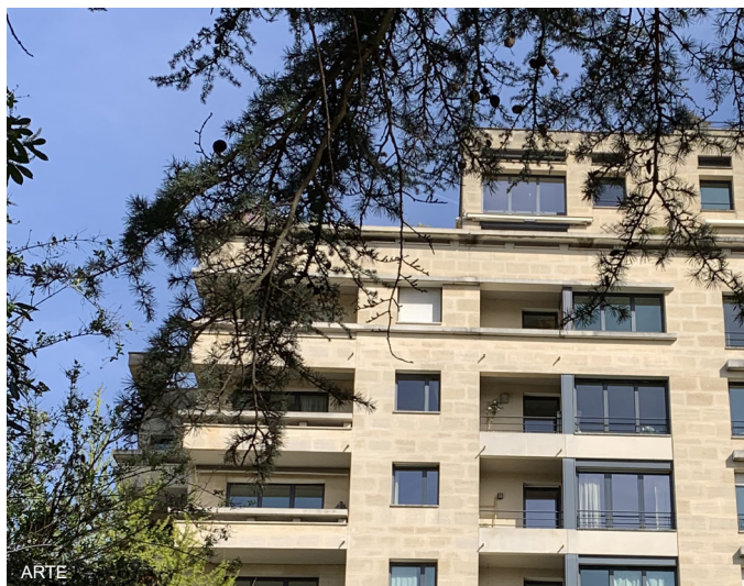
PARIS «FACE AU PARC MONTSOURIS» 92 LOGEMENTS - COGEDIM
