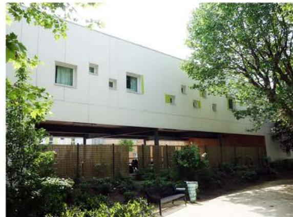
Le groupe scolaire est réalisé en structure bois (murs à ossature et planchers massifs). Le process industrialisé a permis de réduire le délai de construction.
