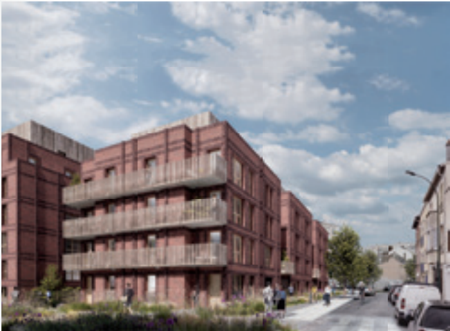
L'îlot Poreux à Bagneux
