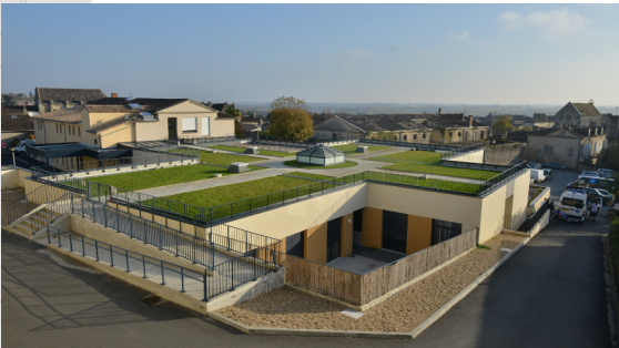
Photo TLR architectes associés
