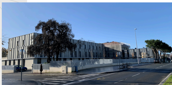
Photo TLR architectes associés
