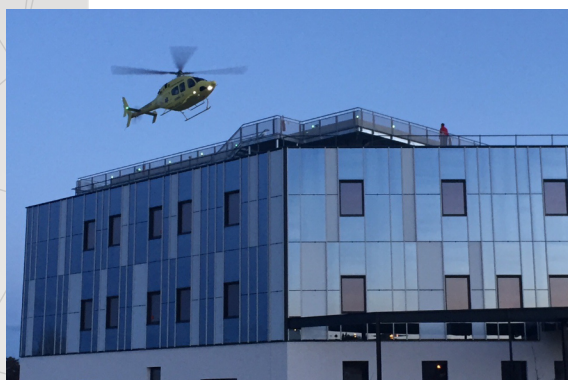
Photo TLR architectes associés
