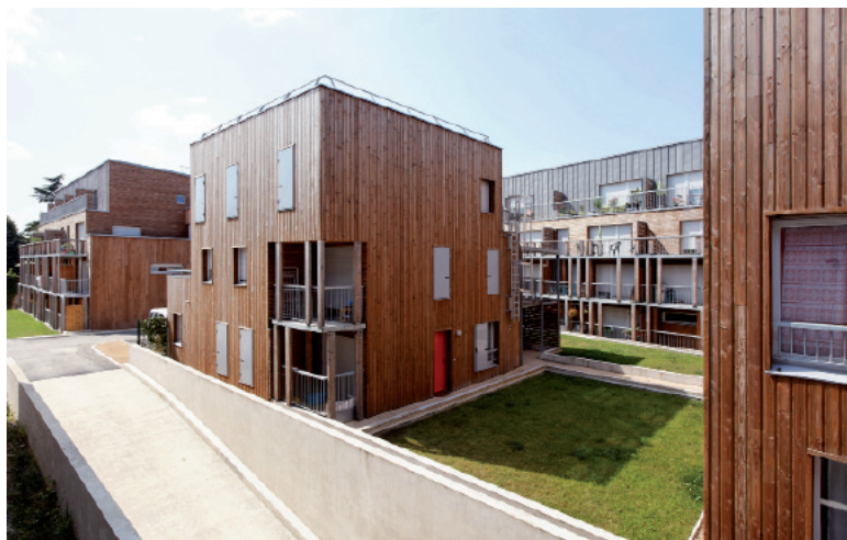
VUE D'ENSEMBLE FACADE SUD BAT ACD
