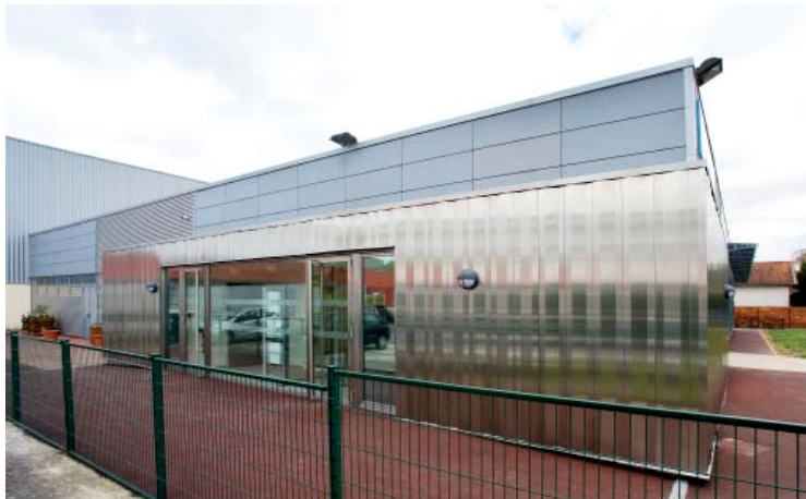
VUE FACADE INOX de l'EXTENSION CREEE
