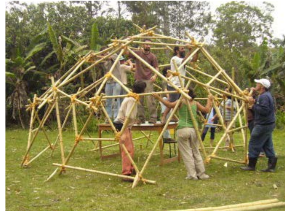
DE TOI EN TOIT / Bambou pour la serre géodésique
