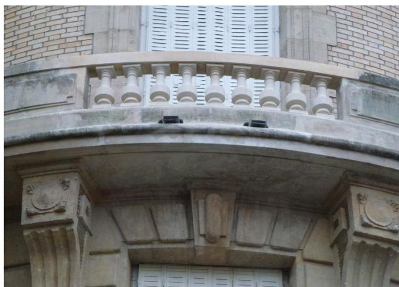
ETAT APRES TRAVAUX – Remise à niveau, ancrage de la dalle, remplacement des balustres et de la main courante
