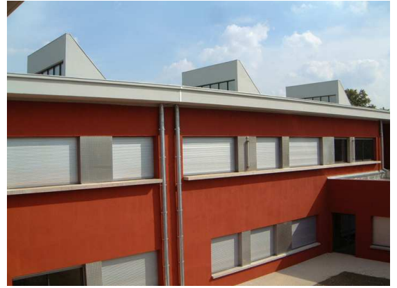
le patio de l'administration – les puits de lumière
