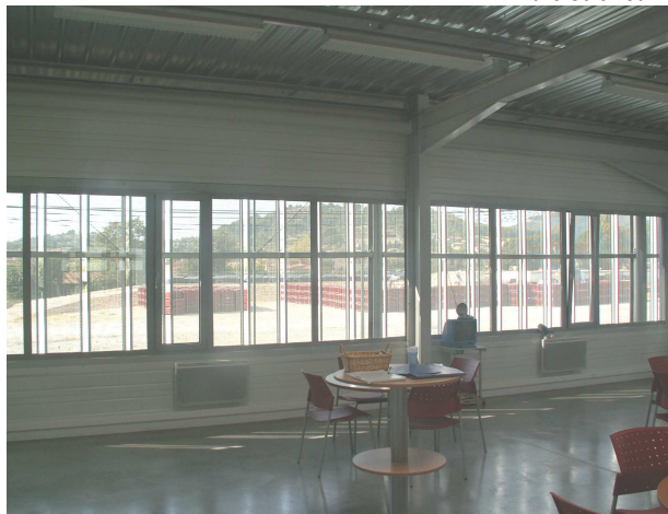
Pare-soleil sur la façade ouest depuis l'intérieur
