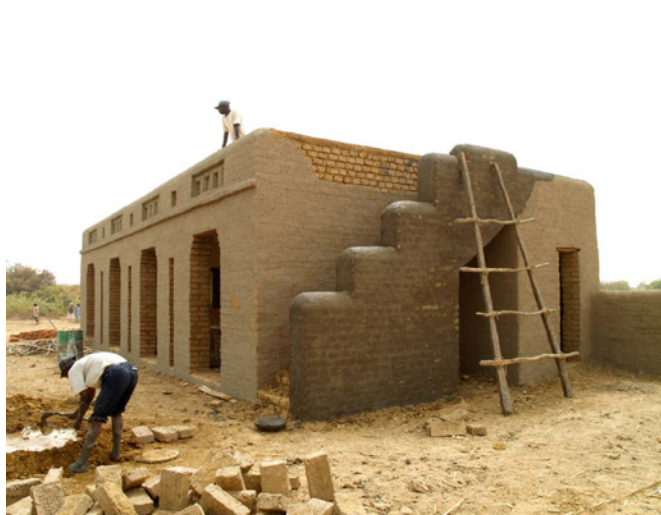
3. Travaux de crepissage
