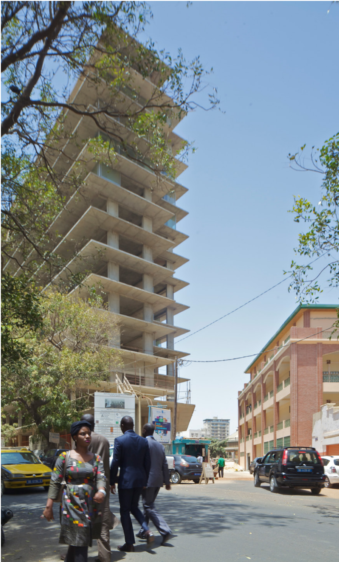
1. Vue depuis l'avenue Hassan II (Juin 2015)
