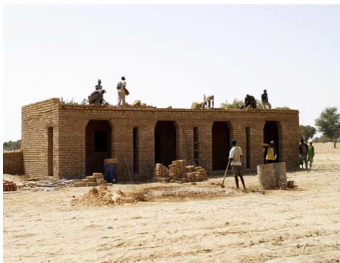
2. Construction du bloc principale
