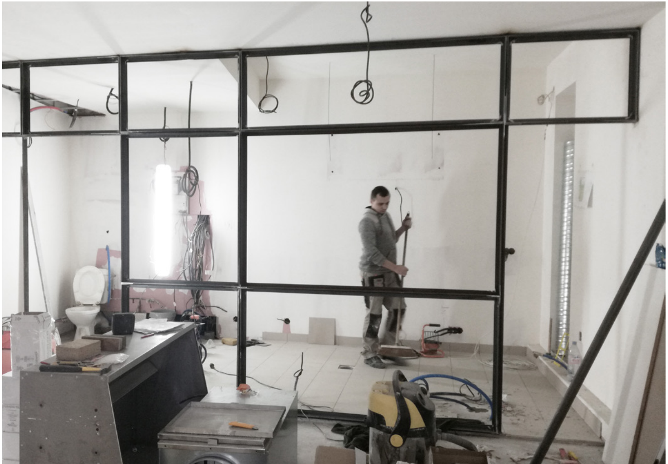
3. Devanture intérieure en construction
