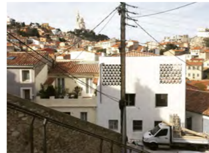
Maison CC LIEU : Marseille (13) MOA : privée PROGRAMME : création d'un niveau supplémentaire et rénovation d'une maison de ville SURFACE : 110 m 2 COUT : 110 000 € HT EQUIPE PROJET : PAN Architecture DATE : 2016
