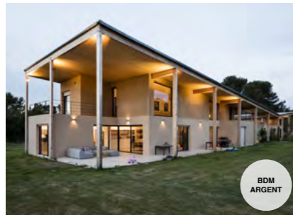
Maison CL LIEU : Aix-en-Provence (13) MOA : privée PROGRAMME : maison individuelle SURFACE : 300 m 2 COUT : 950 000 € HT EQUIPE PROJET : PAN Architecture DATE : 2018 - 2019
