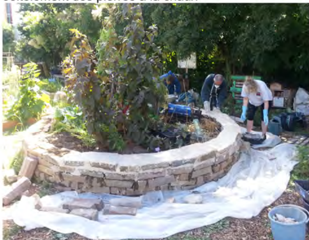
Joitoiement des pierres à la chaux
